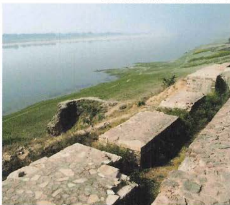
城壁跡からヤナム河を見下ろす
